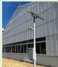
栃木県上三川町
